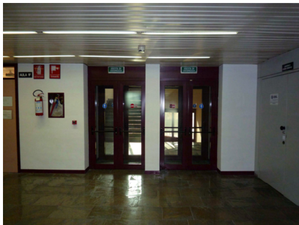
Ingresso scala I, dotata di filtro a prova di fumo
