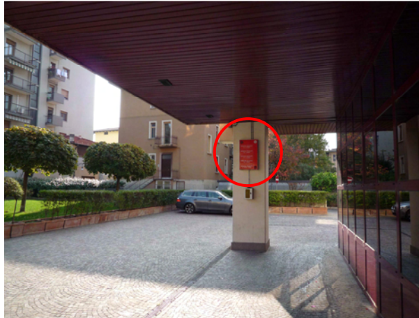
Pannello per la segnalazione della presenza di persone nella scala I
